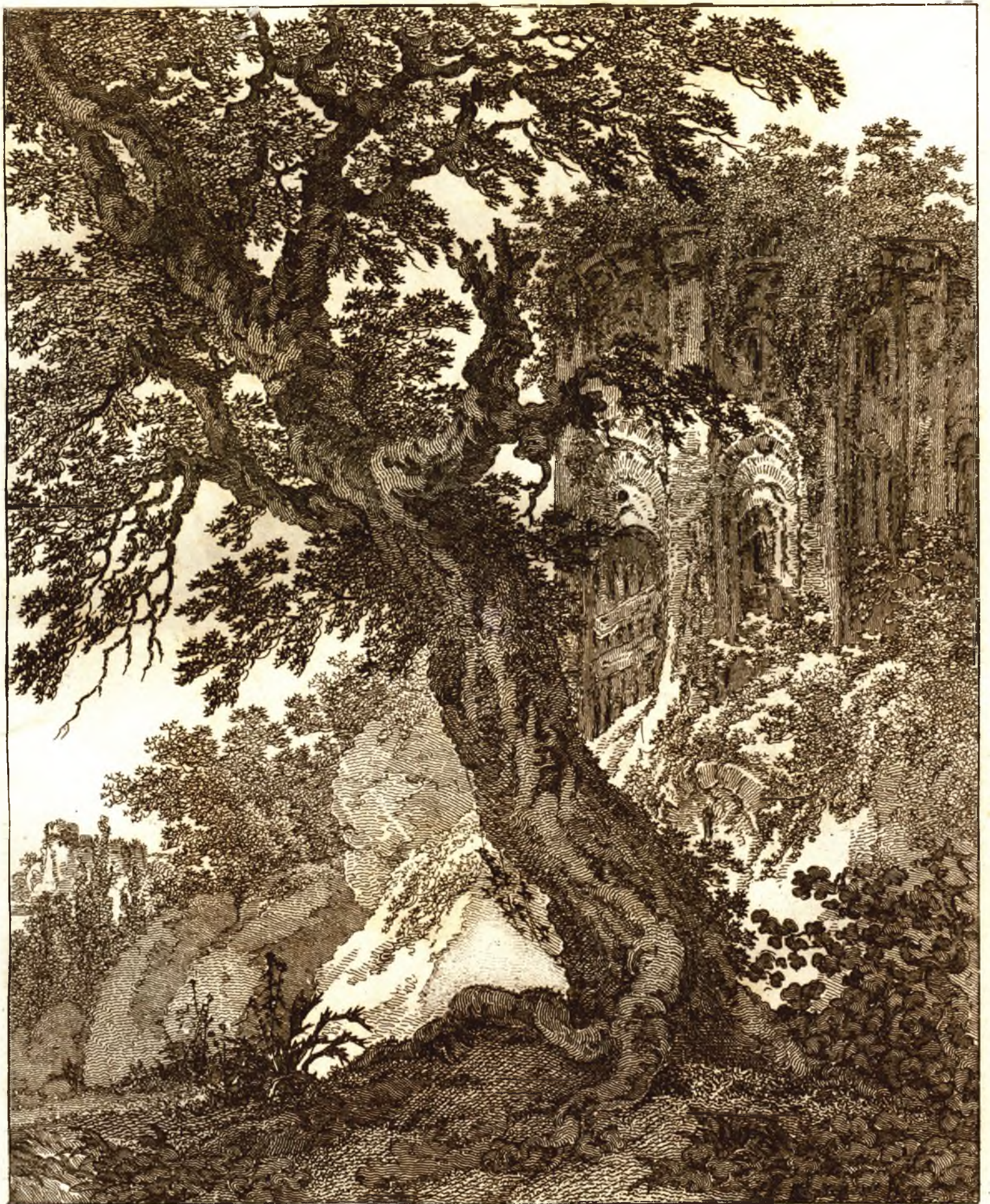
Przyna czyli reszty dawnego Zamku upowaznione Dębem Starym.
