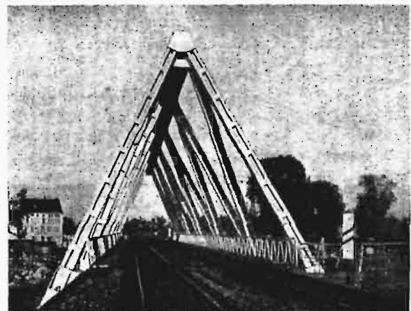
Rys. 1. Widok mostu po wykonaniu.
