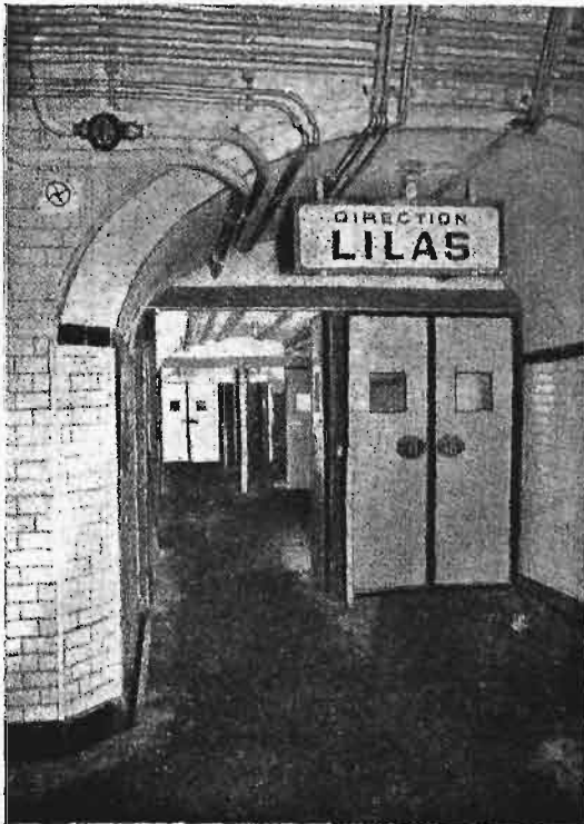
Rys. 3. Drzwi hermetyczne (obok drzwi zamkniętych druga para drzwi otwartych).
