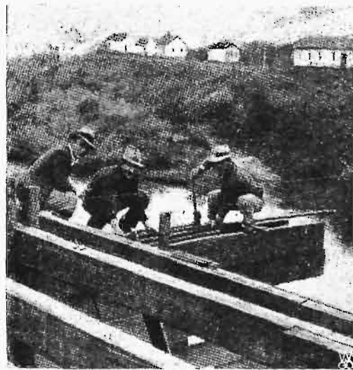
Rys. 3. Zesrubowywanie prętów uzbrojenia z odcinków po 3 m długości.
