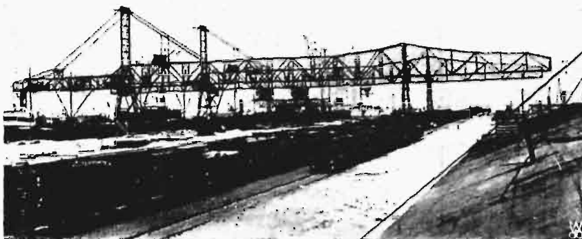
Rys. 12. Most przeładunkowy (w Gdyni) z wózkiem podwieszonym (bud. Huty Zgody).
