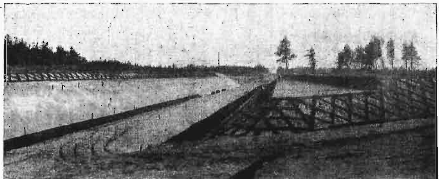
Rys. 4. Wykop na km. 37.
