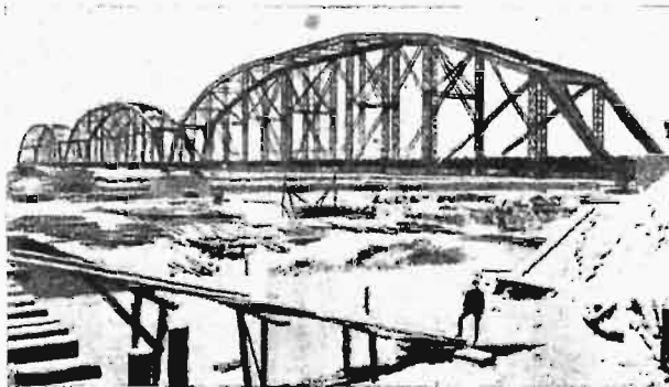
Rys. 1. Odbudowany most kolejowy na Sanie pod Rozwadowem.
