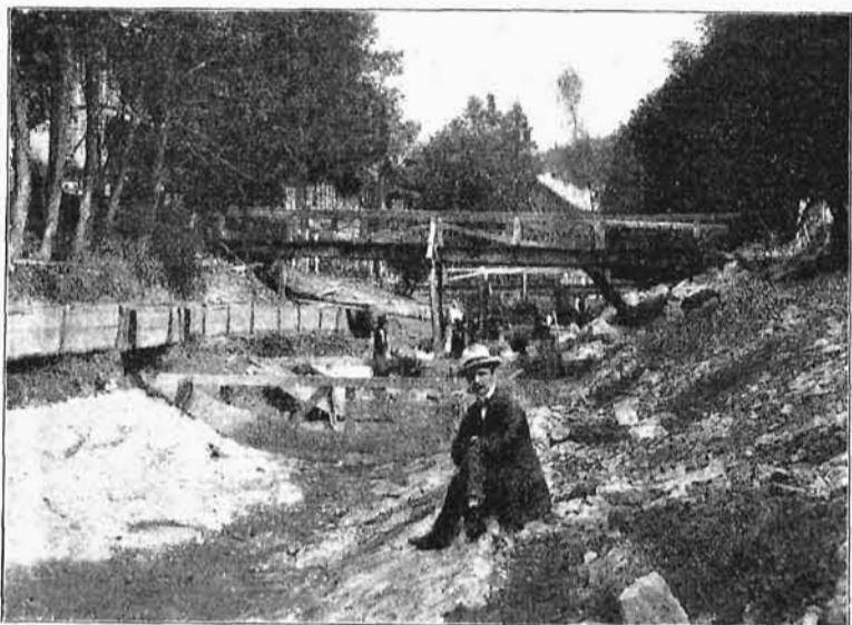
Rys. 5. Żłób Kryniczanki w toku budowy.
