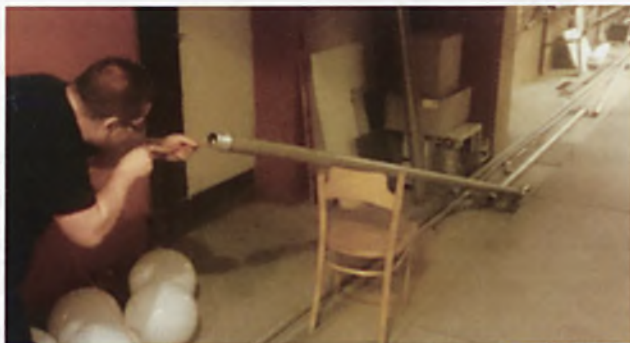
Fot. 2.3. Proces przewlekania przewodów przez uchwyty w rurociągu.
