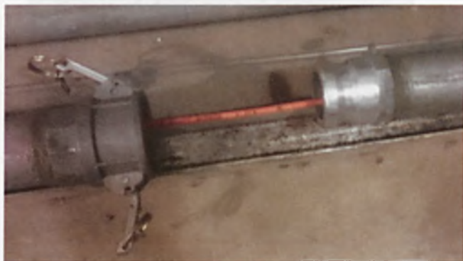
Fot. 2.4. Przewód światłowodowy umocowany wewnątrz rurociągu.
