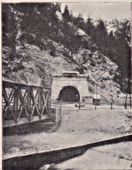
Północny portal tunelu przez Karawanki 7976 m dt.
