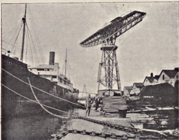
Elektryczny żóraw w arsenale austr. Lloyd'a w Tryeście. Fot. Wł. Martini.
