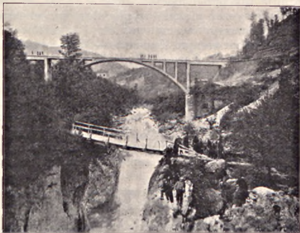
Most żel.-betonowy przez Idryę koło stacyi św. Łucya-Tolmin.
