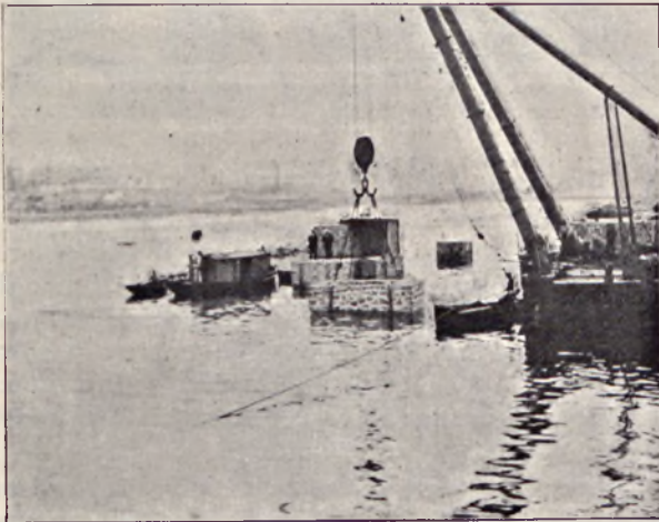
Zapuszczanie bloków pod odpieracz fal.
