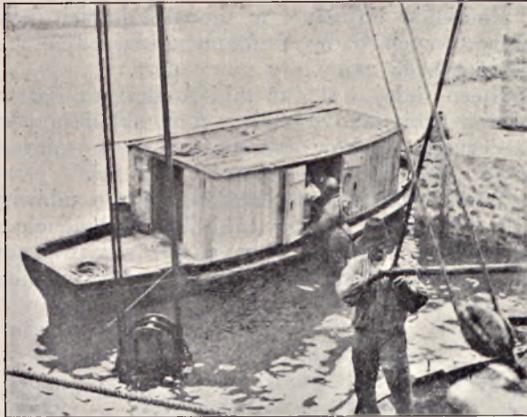
Nurek przy budowie odpieracza fal w Tryeście. Fot. W. Łuczków.
