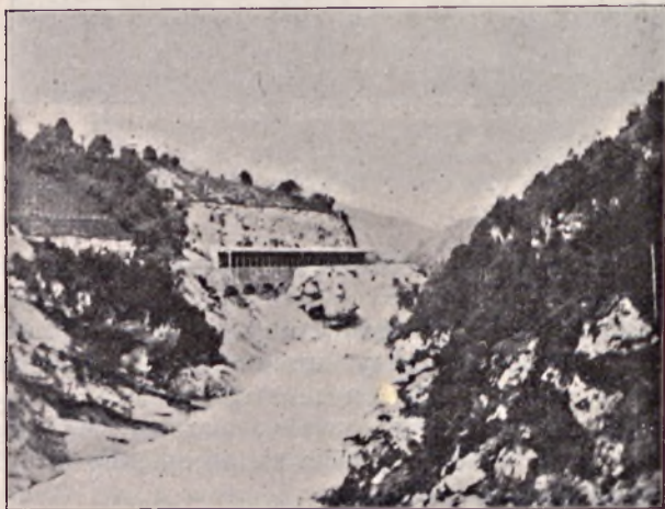
Żel.-betonowa galeria kolei Bahińskiej w dolinie Isonza. Fot. Wł. Lasiński.
