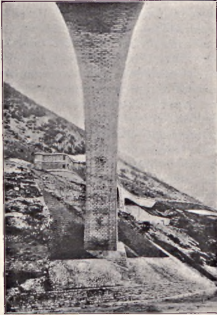
Perspektywa głównego sklepienia kolejowego mostu w Salcano (widok od dołu). Fot. Wł. Martini.
