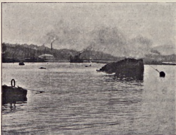
Łódź transportowa, wyladowująca samoczynnie 100 m 3 kamienia w morze. Fot. Wł. Martini.
