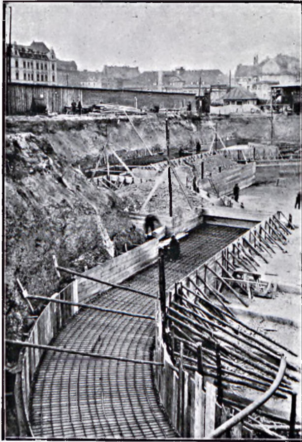
Ryc. 1. Układ wkładek żelaznych fundamentów murów zewnętrznych.
