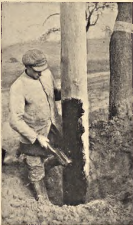
Rys. 32 Smarowanie zaimpregnowanego słupa „Kobrolitem“.
