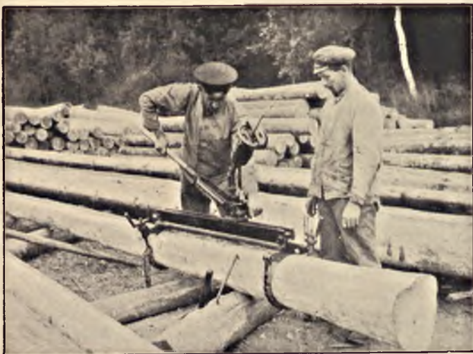
Rys. 26. Impregnowanie metodą Kobra słupów na składzie przy pomocy ręcznej maszyny.
