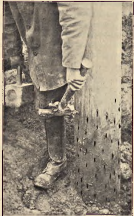
Rys. 31. Impregnowanie metodą Kobra słupów drewnianych już ustawionych na gruncie.
