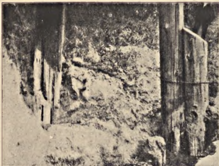
Rys 1 — Gnicie słupów wskutek grzyba drzewnego domowego. Po prawej stronie widać włókna grzybowe t. z. „nici”. (Podl. Valaska).
