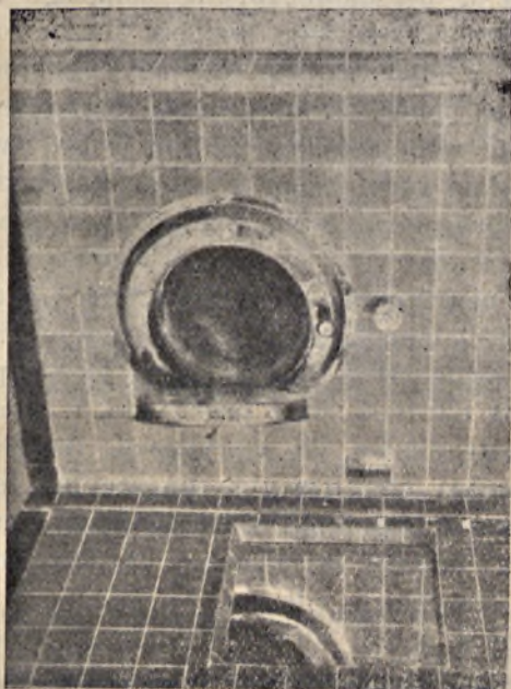
Rys. 23. Wlot szybu do usuwania użytej bielizny z sali operacyjnej, systemu Wedla wykonania Hartmanna (klinika chirurg. w Magdeburgu — Sudenberg).
