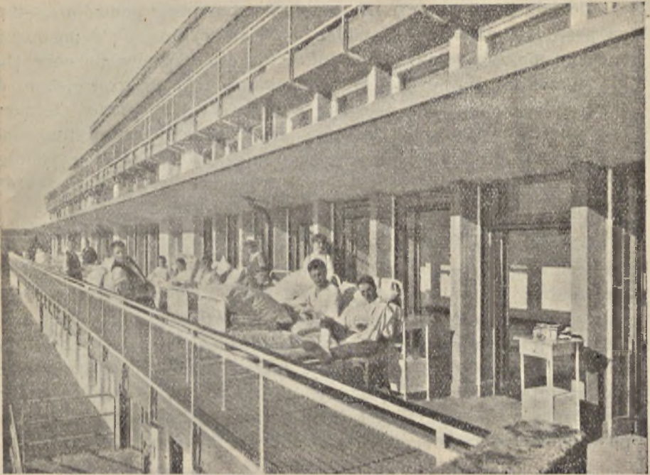
Rys. 2. Balkony komunikujące z salą chorych o jednostronnem oświetleniu (Szpital dla gruźlików Waiblingen, zbud. w r. 1928).
