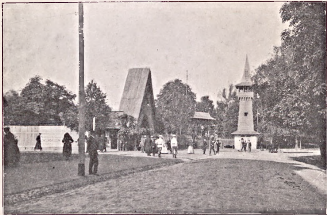
Główne wejście na wystawę.
