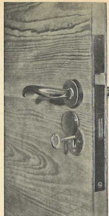
Rys. 11. Szczegół umocowania zamka w drzwiach tępach o grubości 35 mm.
