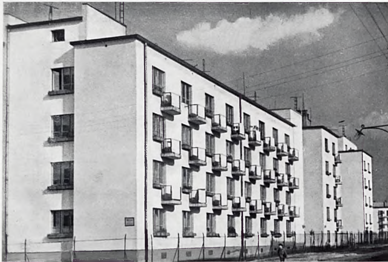
ARCH. JAN KUKULSKI (SARP) Zakład Ubezpieczeń Społecznych — Domy mieszkalne dla robotników. Etablissement des Assurances Sociales — Maison d'habitation pour ouvriers. The Social Insurances Board — Tenement House for Workmen. Sozial - Versicherungsanstalt — Arbeiter Wohnhäuser. Assicurazioni Sociali — Case operaie. Warszawa
