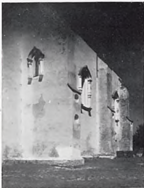
Fig. 29. Zimno. Monaster. Cerkiew Uśpieńska. Szkarpy ściany połudn. Fot. Zakł. A. P.
