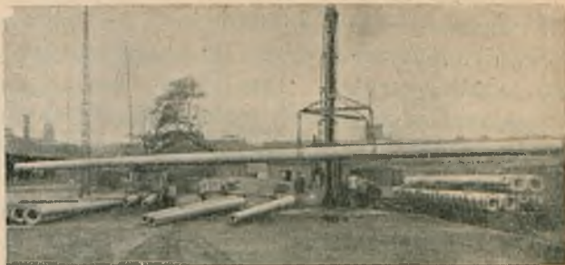
Fig. 4. Układanie na wagonie żelbetowych słupów oświetleniowych, wykonywanych przez wirowanie.
