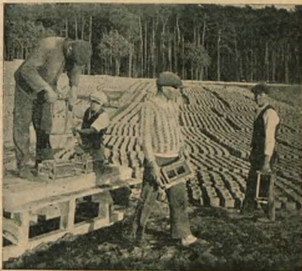
Fig. 3. Wyrób pustaków betonowych „Ideal“ na wolnym terenie.
