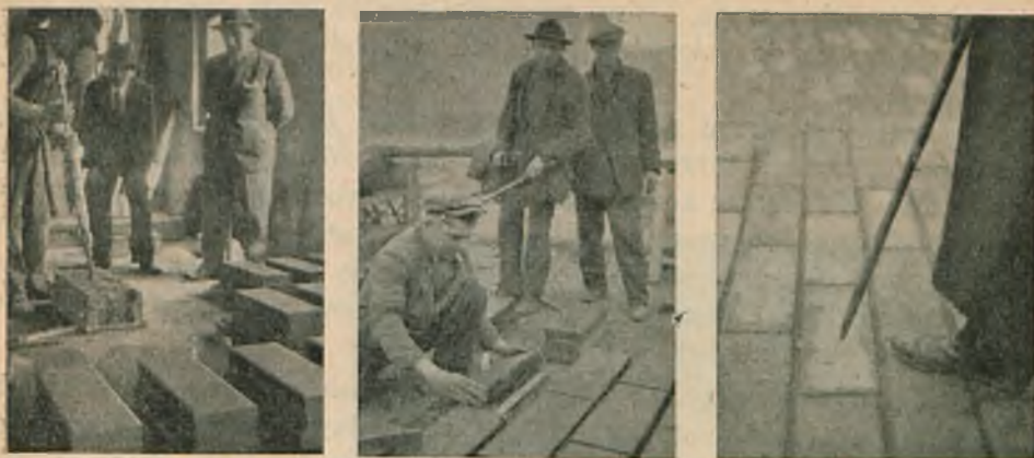
Fig. 2. Wyrób i układanie kostek do brukowania ulic.
