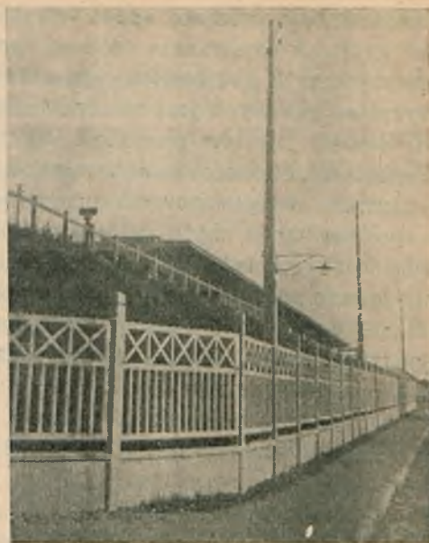
Fig. 5. Ogrózenie z gotowych elementów żelbetowych; obok widoczne latarnie żelbetowe.
