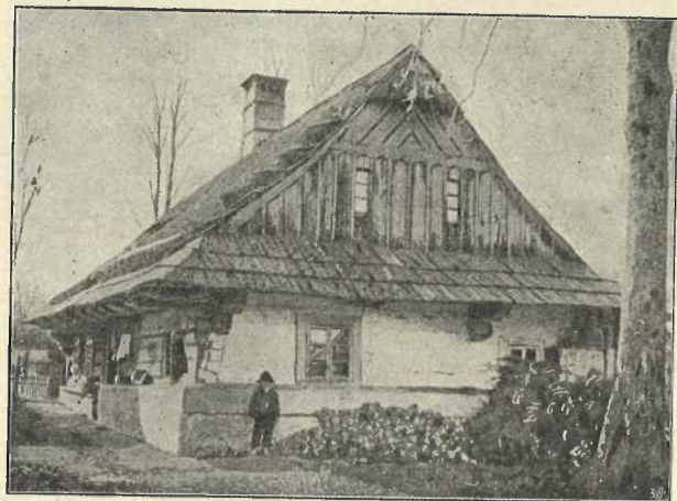
Rys. 14. Śląsk Austryacki, dom w Trzycieźu z r. 1801 ze szczytem i daszkiem przyźbowym. (Glogier. Budown. drzewne).
