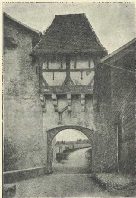
Rys. 65. Hurdcyca nad bramą zamku w Lucens, w kant. Vaud w Szwajcaryi.
