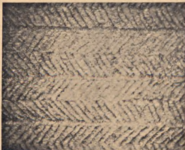
13. Powierzchnia ściany wykonanej ze słomy moczonej w glinie i układanej warstwami — bez szkieletu konstrukcyjnego (okolice Łucka).
