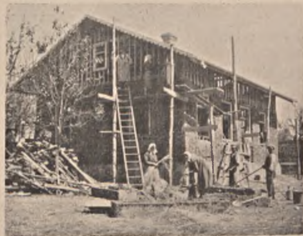
12. Budynek ze słomy moczonej w glinie i wyplatanej na szkielet z drzewa (pow. Bielsk Podlaski).
