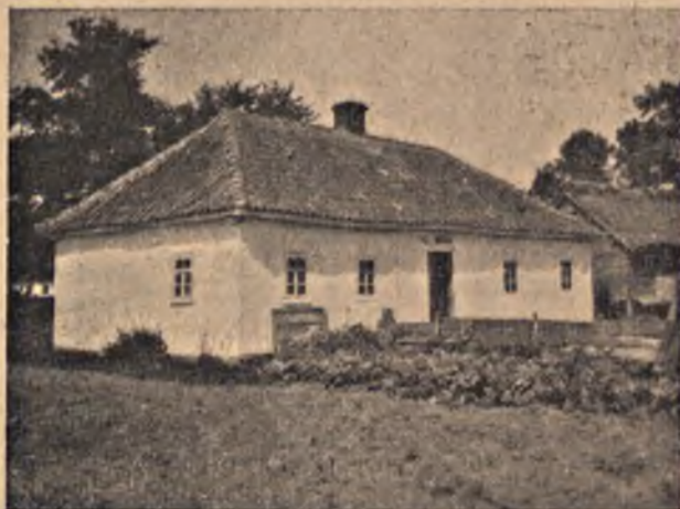
15. Budynek mieszkalny, wykonany ze słomy moczonej w glinie (bez szkieletu), otynkowany i pokryty dachówką.
