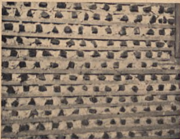
17. Powierzchnia ściany wykonanej z drzewa opałowego, kładzonego na zaprawie wapiennej.
