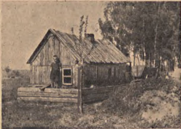
3. Prymitywny budynek mieszkalny w gospodarstwie małorolnym, będący wynikiem niedostatku materiałów budowlanych na wsi.
