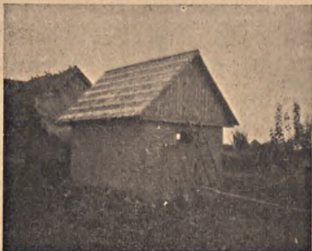
14. Kurnik, wykonany ze słomy moczonej w glinie (bez szkieletu), pokryty gontem — o kubaturze około 35 m sześć. (wydatek całkowity na budulec — bez robocizny — 35 zł).
