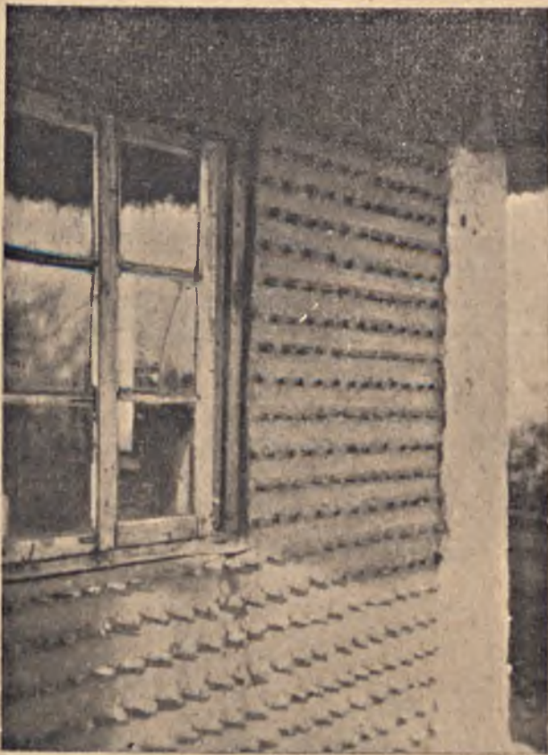
16. Budynek glinobity, przekładany chrustem, równo przyciętym dla podtrzymana wyprawy (Wileńszczyzna).
