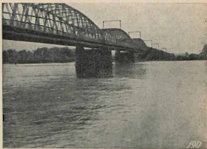
Ryc. 17. Fordon. Most drogowo-kolej. na Wiśle. (Widoczne są przewody wysokiego napięcia z Gródka do Torunia).
