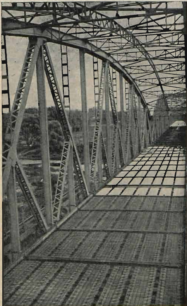
Ryc. 13. Toruń Budowa mostu drogowego na Wiśle. Przęsła środkowe
