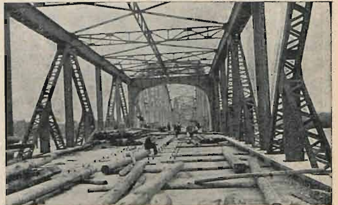
Ryc. 14. Toruń. Budowa mostu drogowego na Wiśle. Przęsła skrajne.
