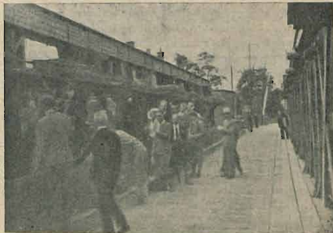
Ryc. 12. Toruń. Wzmocniany most kolej.-drogowy. (po lewej stronie dodatkowa krata wzmocniająca).
