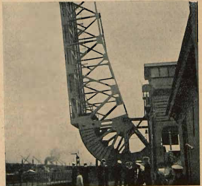
Ryc. 10. Segmentowy most zwodzony (bez przeciwwagi) w Antwerpi.
