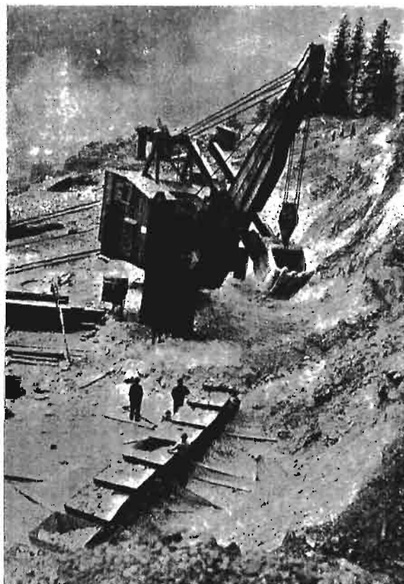
Ryc. 7. Ładowanie rudy na Erzbergu przy pomocy kopaczki elektrycznej na gąsienicach.
