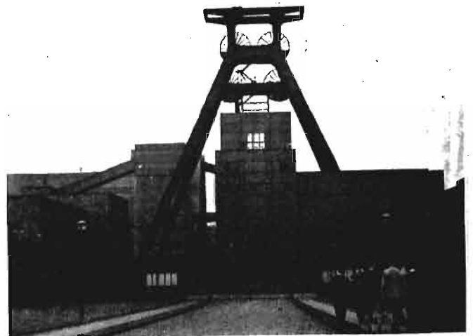
Ryc. 6. Wieża szybowa kopalni węgla „Zollverein” pod Essen.
