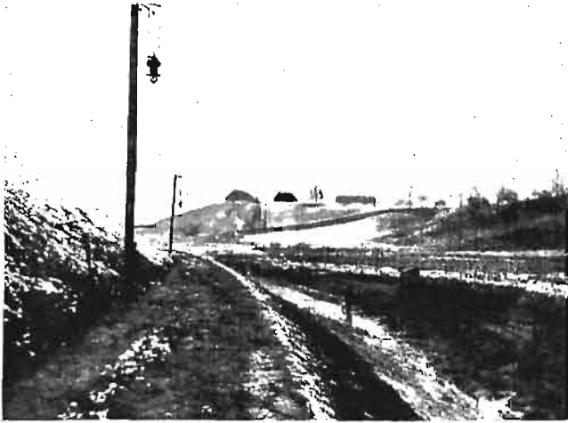
Ryc. 3. Roboty na wododziale. Przekop.
