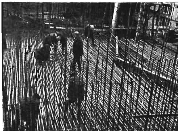
Ryc. 6. Układanie zbrojenia w dnie śluz Morzysławskiej.
