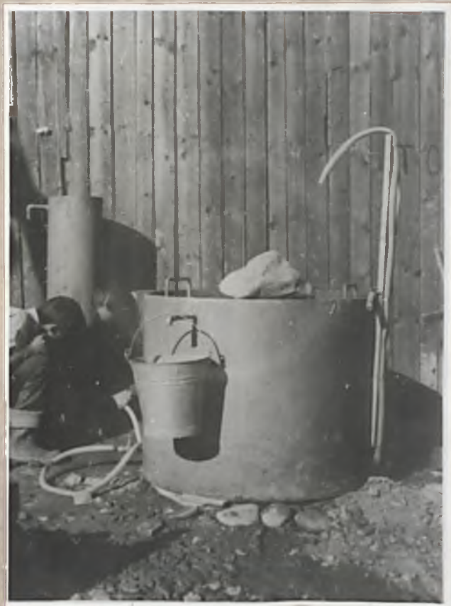
Rys. 10.10. WIELKOWYMIAROWY APARAT DO BADAN WODOPRZEPUSZCZALNOŚCI GRUNTÓW GRUBOKLASTYCZNYCH
