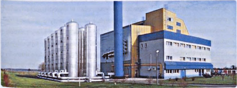
Rysunek 3.16 Widok baterii zasobników ciepła obok budynku EC Fortum w Świebodzicach [49]
