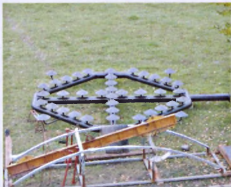
Rysunek 3.14 Dysza górna zasobnika ciepła w trakcie montażu w EC Siedlce (zdjęcia autora)
