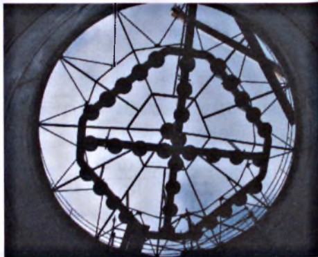
Rysunek 3.14 Dysza górna zasobnika ciepła w trakcie montażu w EC Siedlce (zdjęcia autora)
