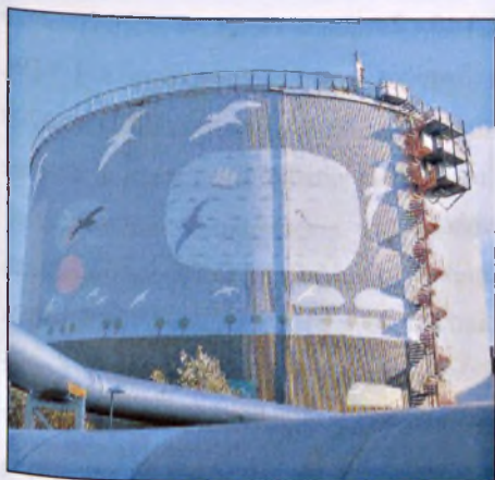
Rysunek 3.12 Zasobnik ciepła pracujący w systemie ciepłowniczym Sztokholmu [45]
