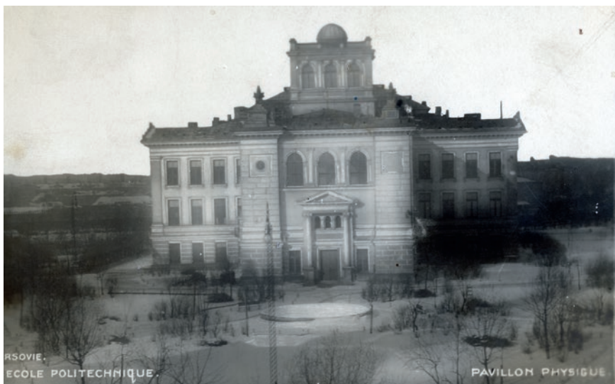
Ryc. 5. Gmach Fizyki w końcowej fazie budowy
