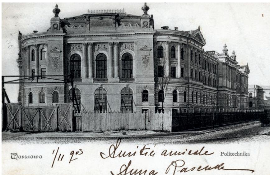
Ryc. 4. Gmach Główny w końcowej fazie budowy w 1901 r. – widok od d. ul. Wiejskiej
