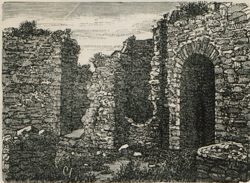
Fig. 12. Studnia w części wschodniej ruin.
