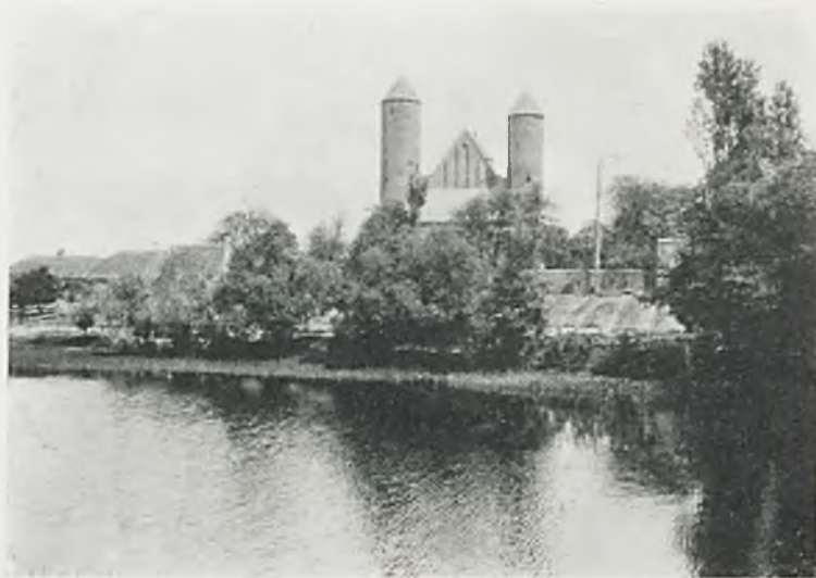
Ryc. 70. Brochów. Kościół św. Rocha. Widok ogólny (przed zniszczeniem).
