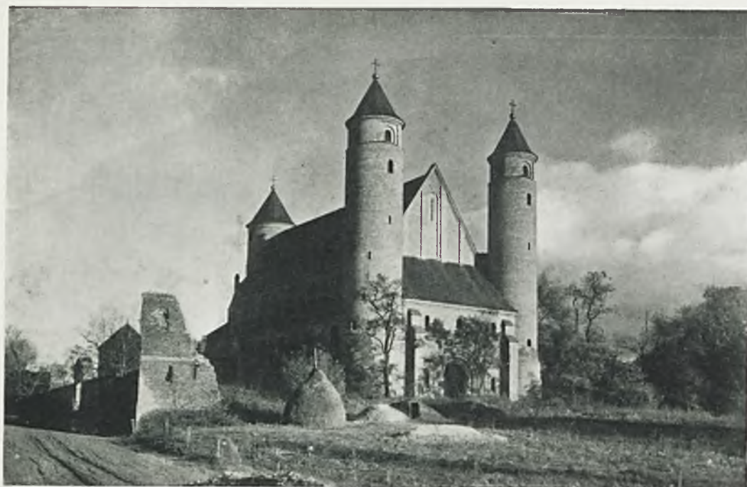
Ryc. 89. Brochów. Kościół św. Rocha. Widok ogólny po odbudowie.
