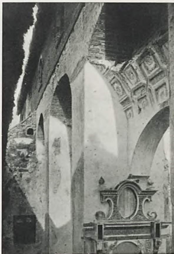
Ryc. 73. Brochów. Kościół św. Rocha. Północna nawa boczna po zburzeniu — u góry arkadowania ponad sklepieniem.
