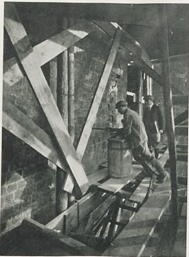
Ryc. 205. Wiercenie otworów swidrem pneumatycznym.
