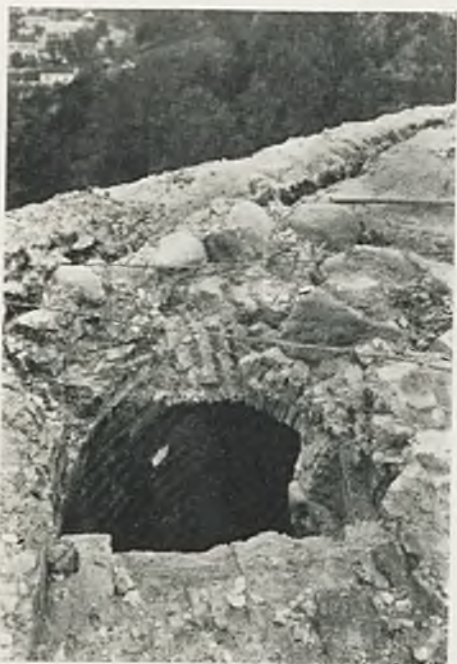
Ryc. 152. Wilno. Zamek Górny. Wylot górny klatki schodowej w baszcie.
