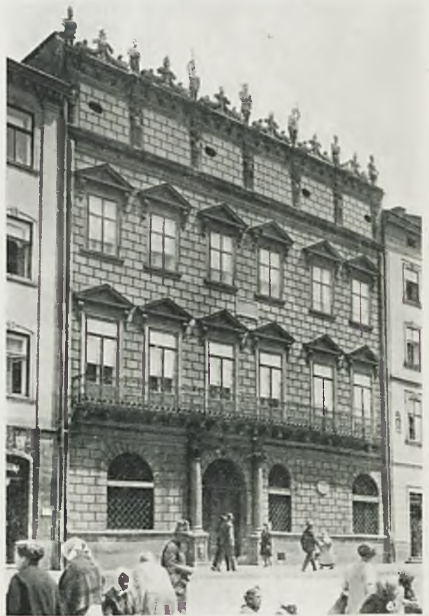
Ryc. 90. Lwów. Kamienica królewska. Fasada frontowa od strony Rynku.
