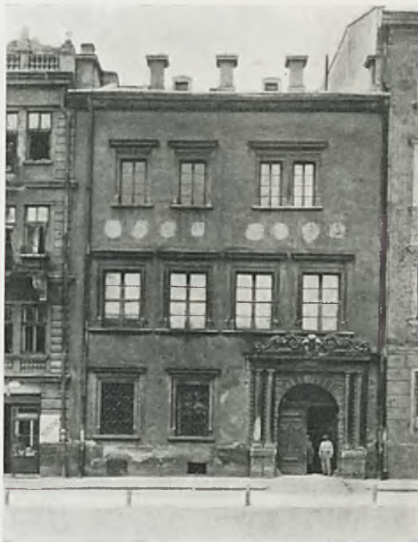
Ryc. 92. Lwów. Kamienica królewska. Fasada tylna przy ul. Blacharskiej Nr. 10.
