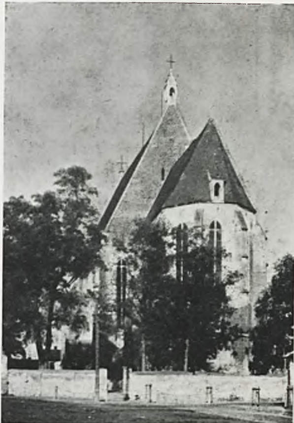
Ryc. 65. Wiślica. Kolegiata. Nowa sygnaturka na wschodnim szczycie nawy.
