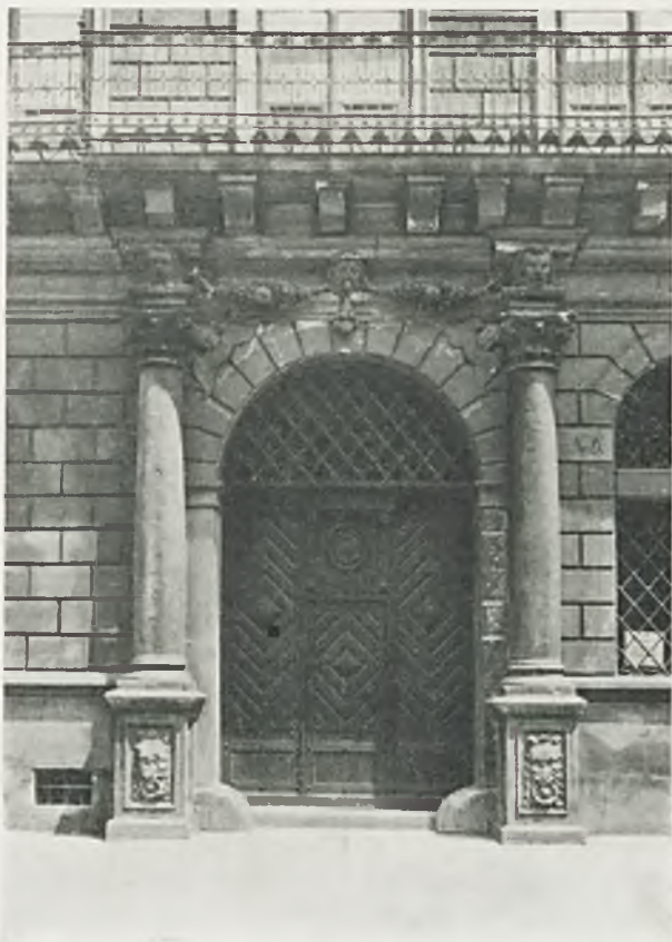
Ryc. 93. Lwów. Kamienica królewska. Portal od strony Rynku.
