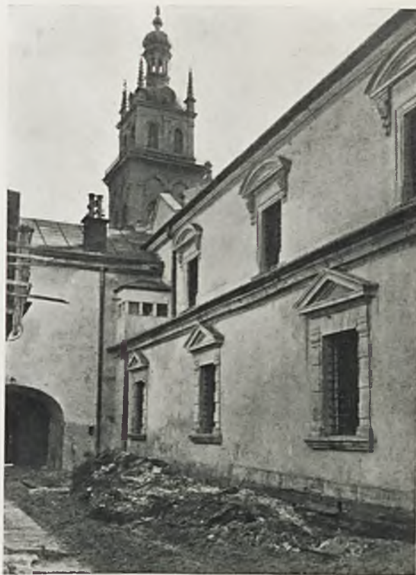
Ryc. 129. Lwów. Arsenal królewski. Część fasady bocznej po odnowieniu.
