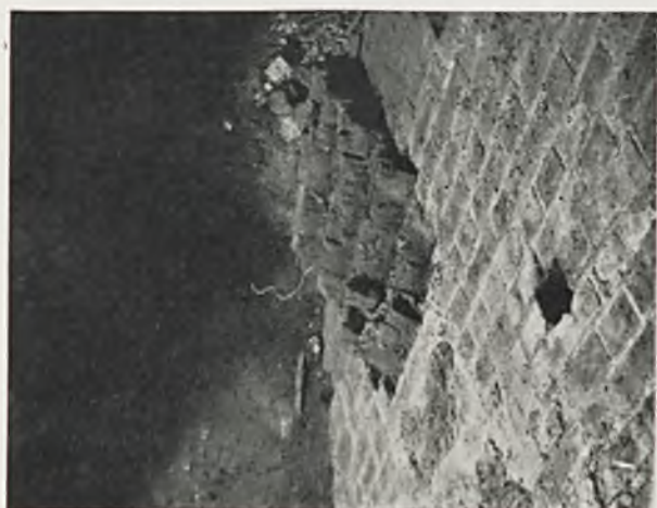
Ryc. 27. Kraków. Kościół N. M. P. Opory łuków odpornych, obecnie pod dachem nawy bocznej.
