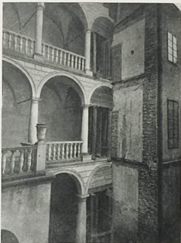
Ryc. 96. Lwów. Kamienica królewska. Fragment nowo wybudowanych arkad i dawne oficyny.
