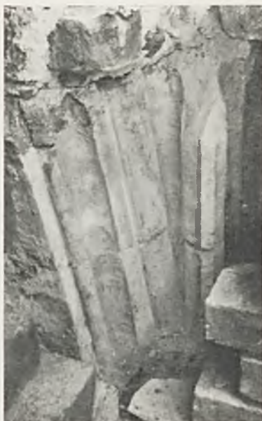
Ryc. 47. Kraków. Kościół N. M. P. Kamień profilowany sklepiennych oporów istniejących w murze.
