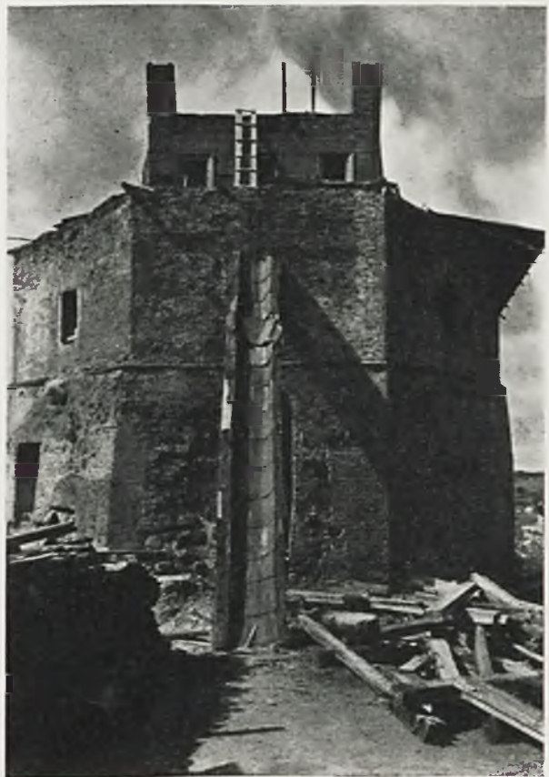
Ryc. 151. Wilno. Zamek Górny. Rozbiórka nadbudówki nad basztą.
