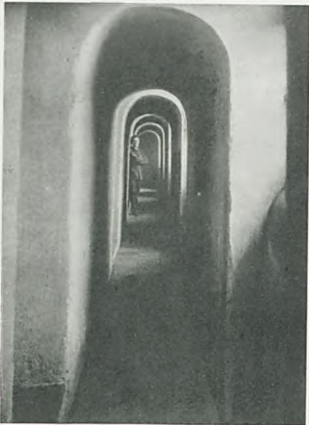
Ryc. 74. Brochów. Kościół św. Rocha. Korytarz obronny.
