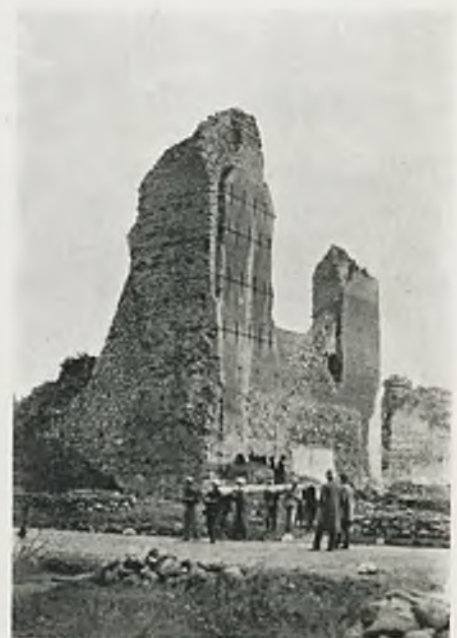
Ryc. 146. Krewo. Ruiny wieży zamkowej po zdjęciu rusztowań w r. 1930.
