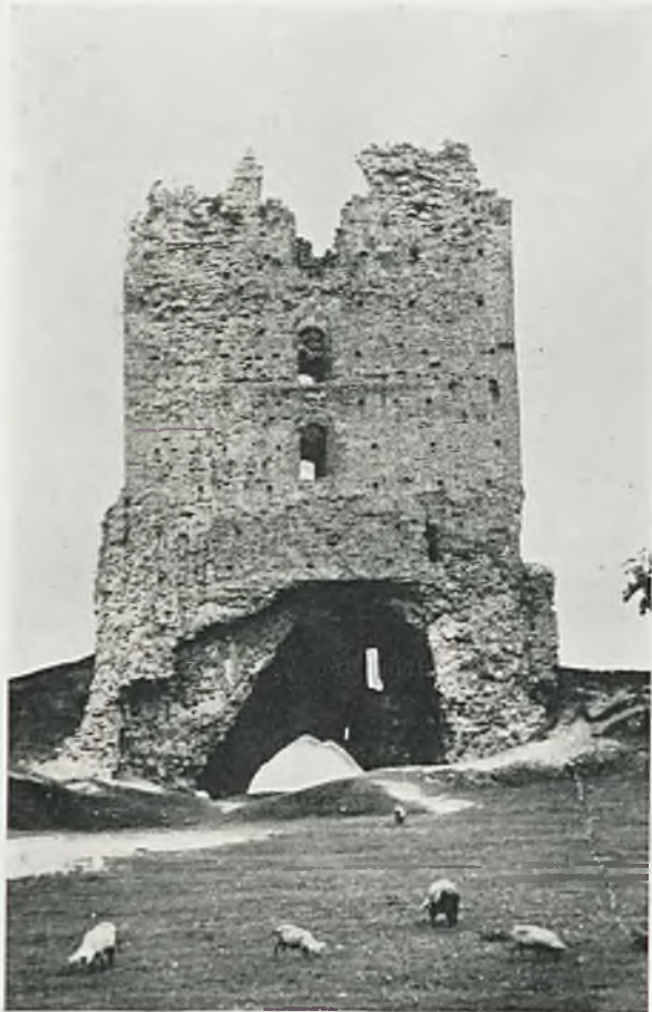
Ryc. 173. Nowogródek. Ruiny zamku. Baszta środkowa przed zawaleniem się ściany od dziedzińca.
