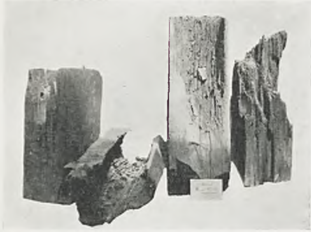
Ryc. 11. Kraków. Kościół N. M. P. Drzewo z konstrukcji dachowej przed restauracją.
