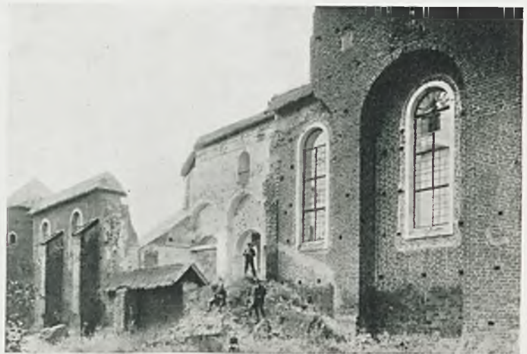
Ryc. 75. Brochów. Kościół św. Rocha. Strona południowa po zburzeniu.
