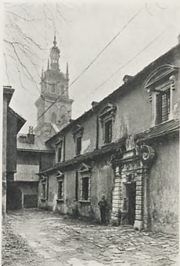
Ryc. 121. Lwów. Arsenał królewski. Fasada boczna przed odnowieniem.
