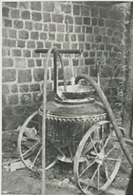
Ryc. 202. Torkret do zastrzyków wodą i zaprawą cementową.
