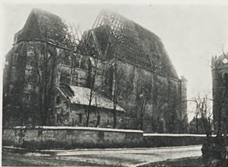
Ryc. 55. Wislica. Kolegiata. Ściana półn. ze zniszczonymi dachami.
