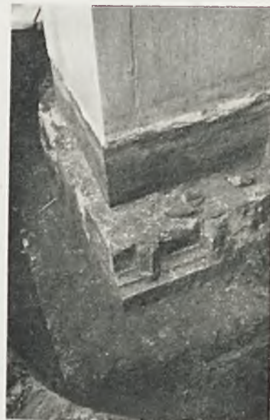
Ryc. 40. Kraków. Kościół N. M. P. Plan fundamentów kruchty głównej z odnalezionymi ciosami epoki gotyckiej.
