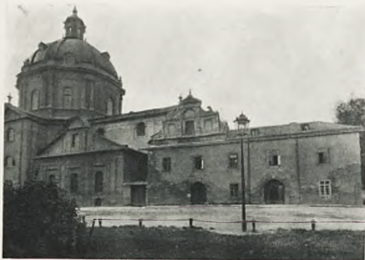
Ryc. 119. Lwów. Arsenał królewski. Fasada frontowa przed odnowieniem.
