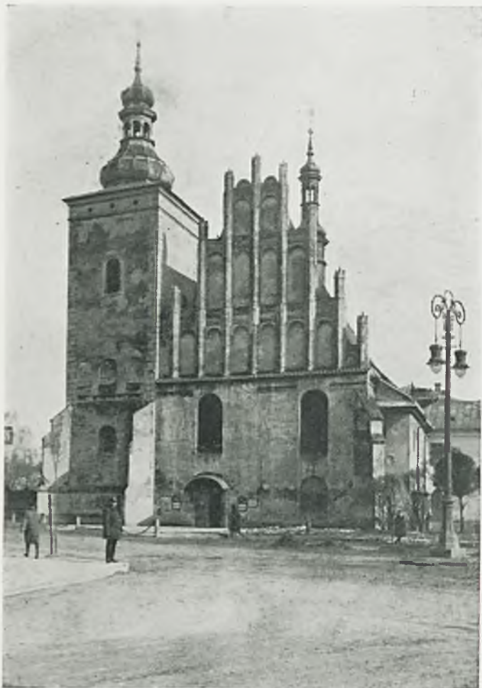
Ryc. 102. Lublin. Kościół N. M. P. Zwycięskiej. Elewacja frontowa przed odbiciem tynków.
