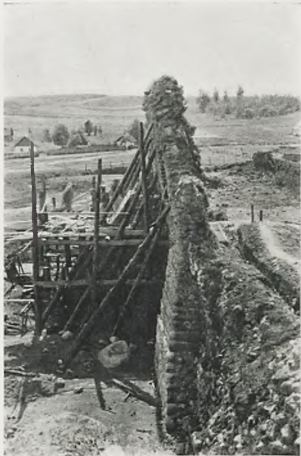
Ryc. 143. Krewo. Ruiny zamku. Murowanie skarpy przy pochylonej ścianie północnej.
