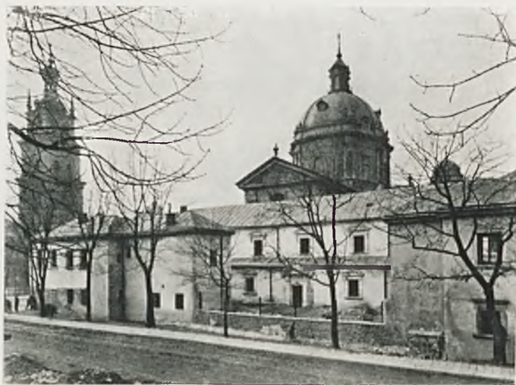
Ryc. 128. Lwów. Arsenał królewski. Fasada boczna po odnowieniu.
