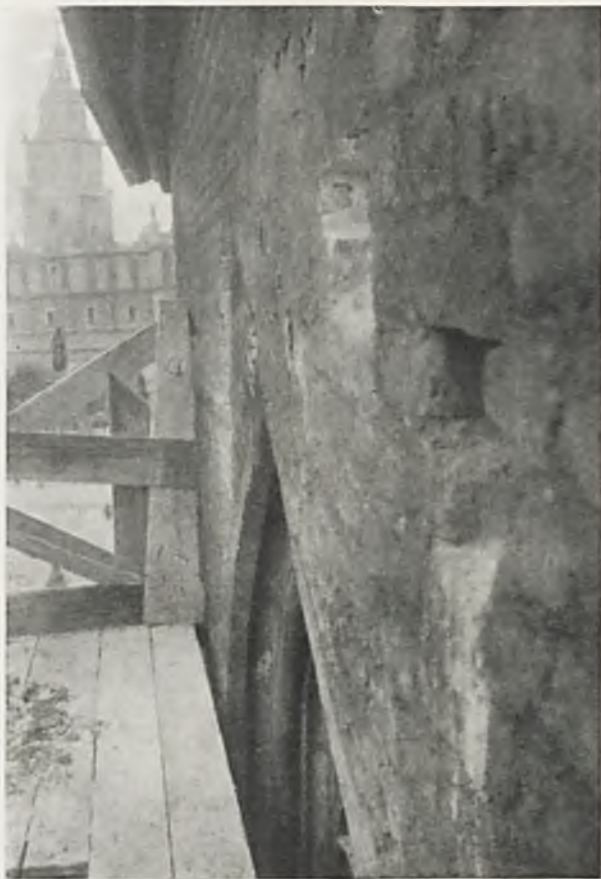
Ryc. 17. Kraków. Kościół N. M. P. Nachylenie okna I-go od Rynku.
