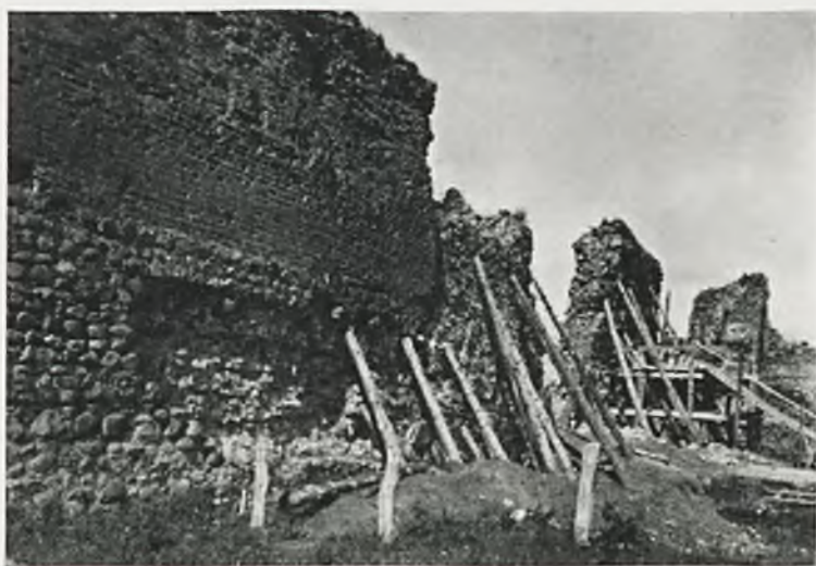
Ryc. 144. Krewo. Ruiny zamku. Konserwacja ściany północnej.
