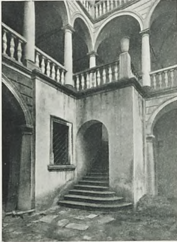
Ryc. 99. Lwów. Kamienica królewska. Nowa klatka schodowa w dziedzińcu (r. 1928).
