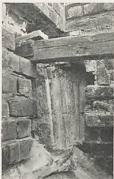
Ryc. 46. Kraków. Kościół N. M. P. Kamień profilowany sklepiennych oporów istniejących w murze.
