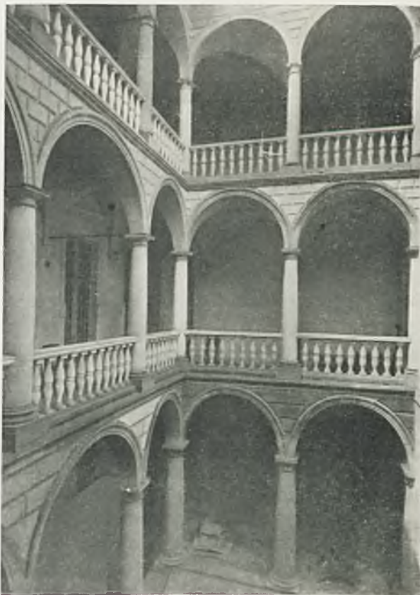
Ryc. 100. Lwów. Kamienica królewska. Naroże przedbudowanych arkad między frontowym budynkiem a oficyną lewą.
