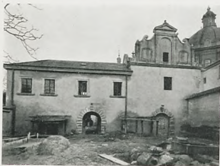
Ryc. 123. Lwów. Arsenał królewski. Fasada tylna w trakcie restauracji.
