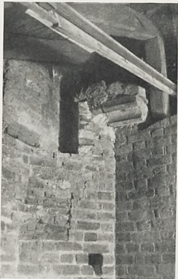
Ryc. 25. Kraków. Kościół N. M. P. Gzyms nawy bocznej.
