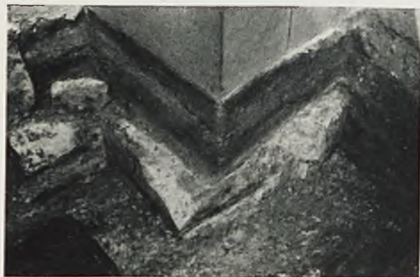
Ryc. 42—45. Kraków. Kościół. N. M. P. Ciosy profilowane w fundamentach kruchty głównej.
