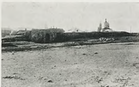
Ryc. 187. Nowogródek. Ruiny zamku. Mury obronne przy baszcie wejściowej.
