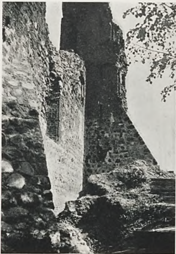
Ryc. 168. N. Troki. Zamek główny na wyspie. Wieża po wymurowaniu skarp.
