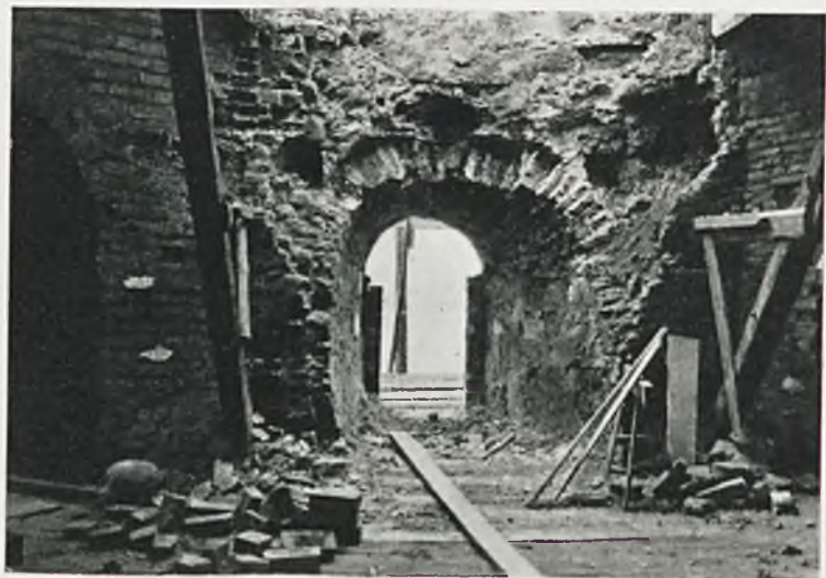
Ryc. 149. Wilno. Zamek Górny. Wnętrze baszty (II piętro).
