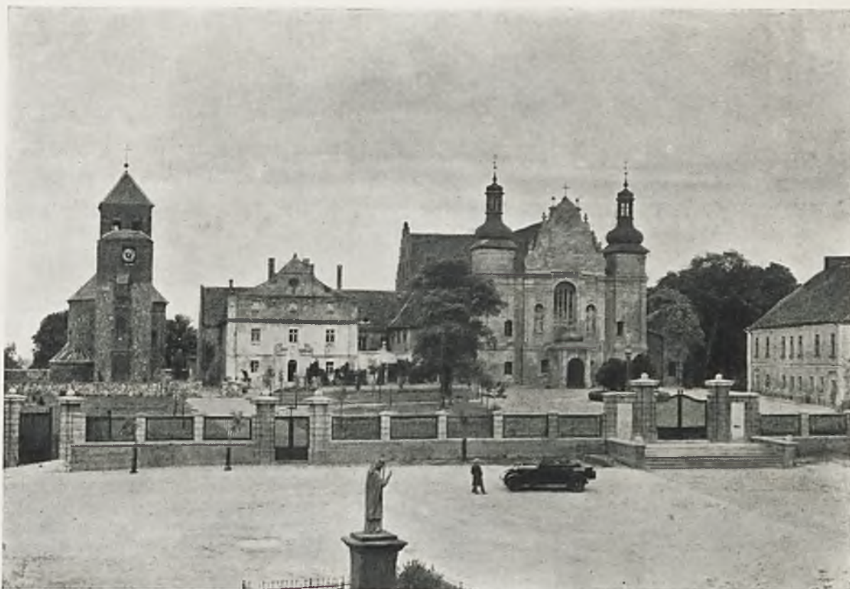
Ryc. 140. Strzelno. Zabudowania kościelne po uporządkowaniu dziedzińca.
