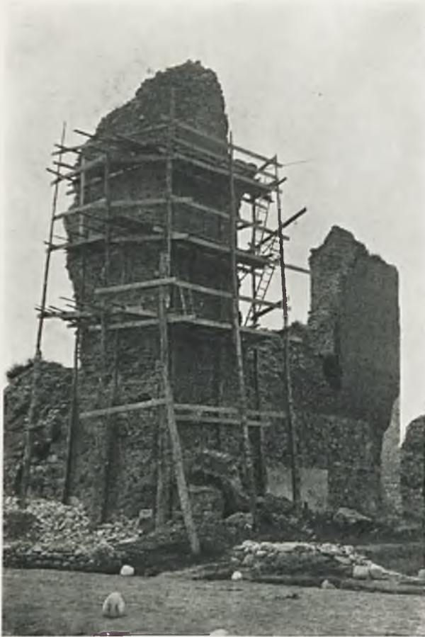
Ryc. 145. Krewo. Ruiny wieży zamkowej w czasie konserwacji w r. 1930.
