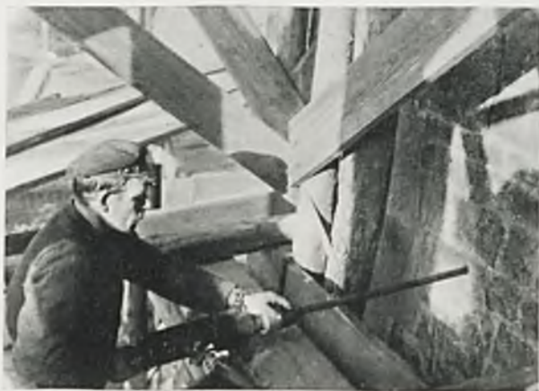
Ryc. 203. Wiercenie otworów świdrem pneumatyczn.
