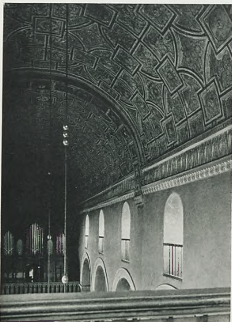
Ryc. 80. Brochów. Kościół św. Rocha. Sklepienie przed zburzeniem.
