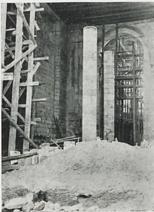
Ryc. 60. Wislica. Kolegjata. Wnętrze w czasie odbudowy.
