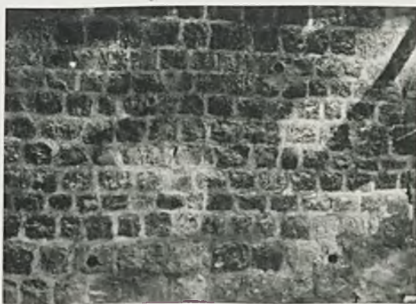
Ryc. 204. Mur wieży z wywierconymi otworami.
