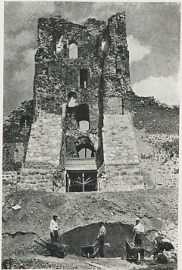
Ryc. 167. N. Troki. Zamek główny na wyspie. Konserwacja wieży i bramy wjazdowej.
