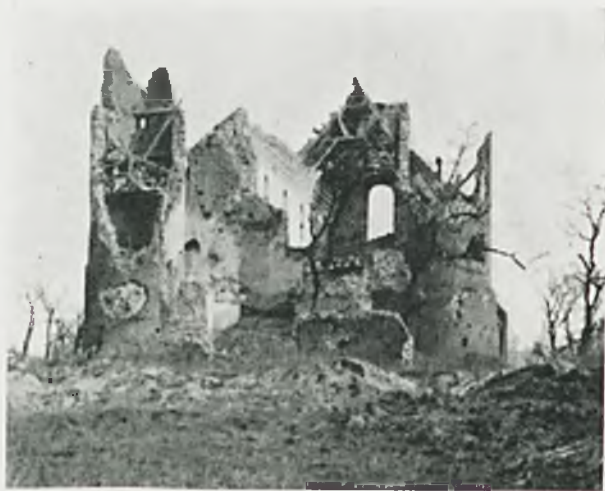
Ryc. 84. Brochów. Kościół św. Rocha. Wieże zachodnie po zburzeniu.
