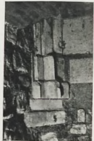
Ryc. 23. Kraków. Kościół N. M. P. Ciosy pod wieżą niższą.
