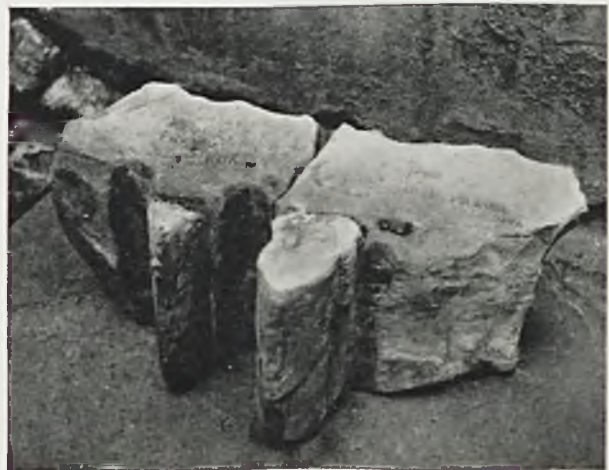
Ryc. 39. Kraków. Kościół N. M. P. Kamień o profilu gotyckim z ościeży bramy głównej.
