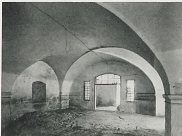
Ryc. 132. Lwów. Arsenał królewski. Wnętrze hali parterowej z częścią dawnej stajni.
