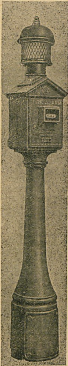
Rys. 5. Skrzynka z ostrzegaczem ulicznym i aparatem telefonicznym wewnątrz oraz z lampą sygnalizacyjną na zewnątrz, na postumencie.
