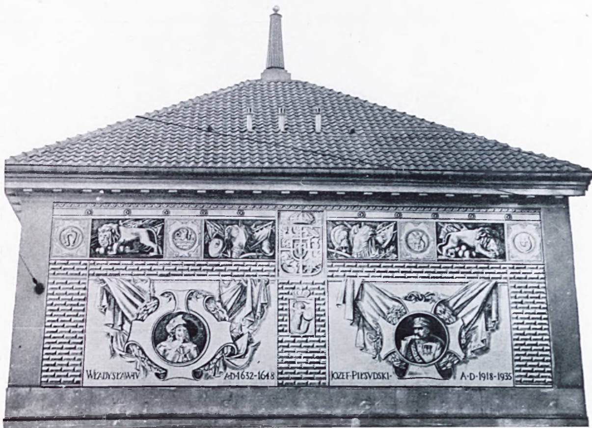
60. L. Pękałski. Dekoracja ściany zewnętrznej dawnego arsenału w Warszawie. Sgraffito.
