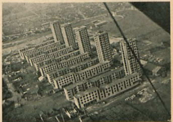
Rys. 11. Widok z lotu ptaka kolonii robotniczej w Drancy.
