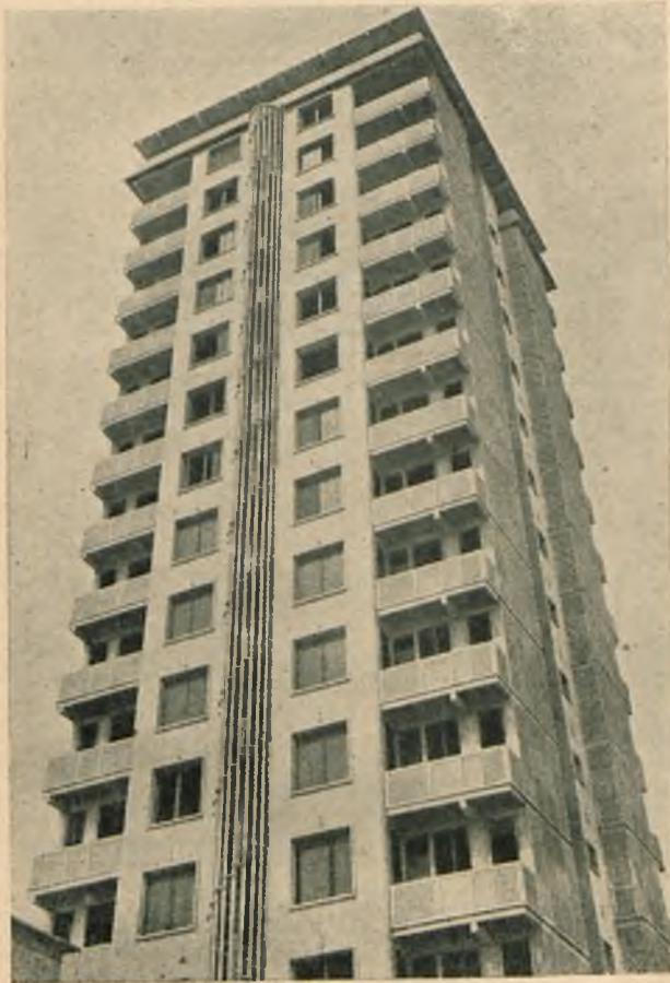
Rys. 10. Jeden z pięciu „drapaczy nieba” kolonii robotniczej w Drancy pod Paryżem budowanej wg systemu E. M. Charakterystyczne ażurowe balustrady balkonowe z elementów żelbetowych i ażurowe ściany suszarni domowych. Środkowy pas to schody pomocnicze — pożarowe ażurowe składane z elementów żelbetowych gotowych. Schody są całkowicie otwarte dzięki czemu w czasie pożaru nie grozi im niebezpieczeństwo zbytznego nagrzania się.
