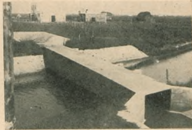
Fig. 6. Skrzyżowanie kanałów, posiadających dno w różnych poziomach (fotografia własna).
