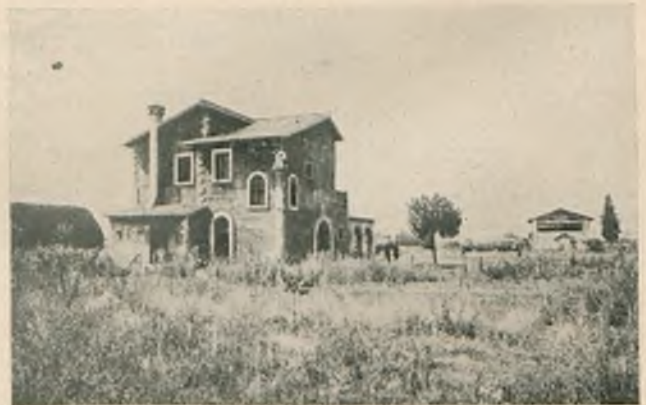
Fig. 10. Widok jednego z domów osadniczych z charakterystycznym dla budownictwa włoskiego przewodem kominowym, wyprowadzonym nazewnątrz budynku.
