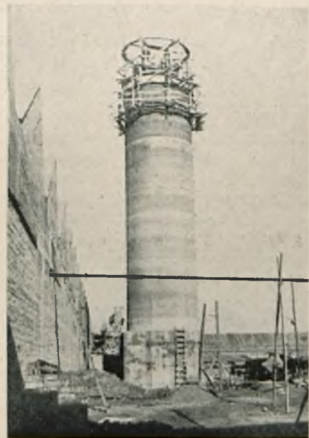
Rys. 3. Komin I w 5 dni po rozpoczęciu betonowania trzonu.
