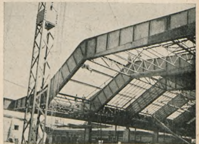
Rys. 4. Więzary — blachownice spawane. W dolnej części więzarów widoczna jest blacha nakrywająca dolny pas, którą zastosowano ze względów estetycznych jako część więzara widoczną od wewnątrz.
