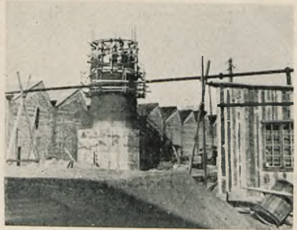
Rys. 2. Komin I w dwa dni po rozpoczęciu betonowania trzonu.
