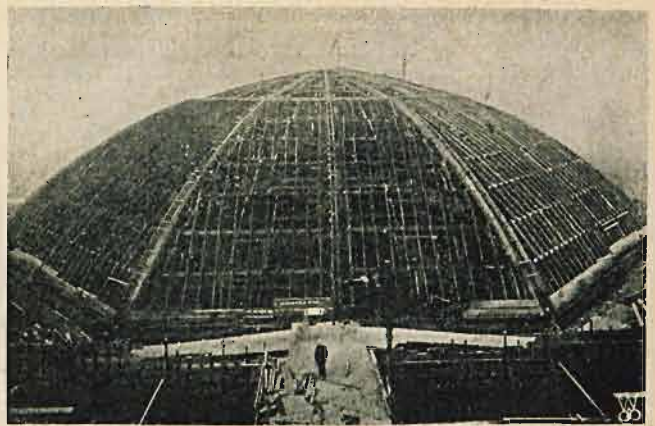
Rys. 6. Widok szalowania (bez deskowania płyt).
