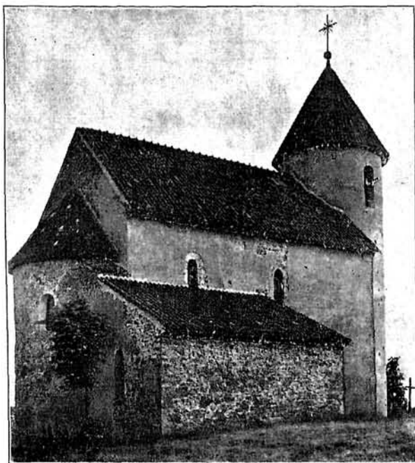
Ryc. 1. Stan kościoła w 1936 r. widok z północo-wschodu.
