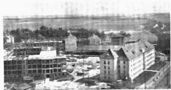
Fragmenty z budowy.
