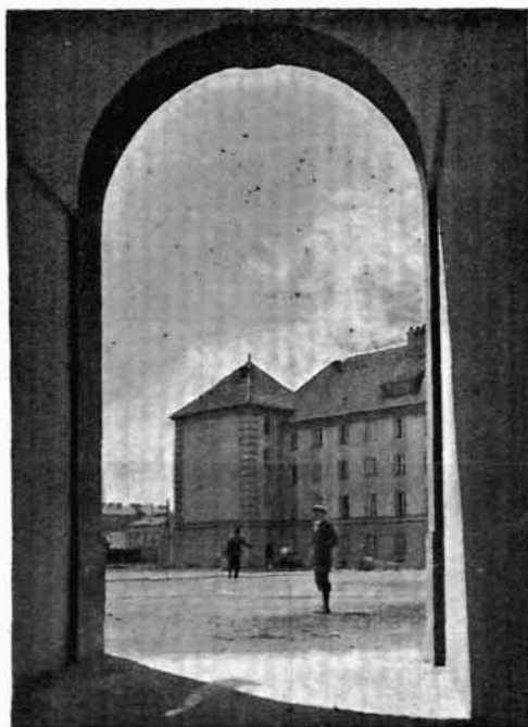
Widok pawilonu bocznego od strony dziedzińca.
